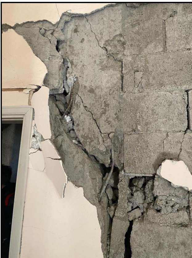
Foto 9 – Fratturazione al suolo e danneggiamento alle strutture portanti di un edificio ubicato in Via Fortino Fleri (Poggiofelice) a seguito del terremoto del 26.12.2018
