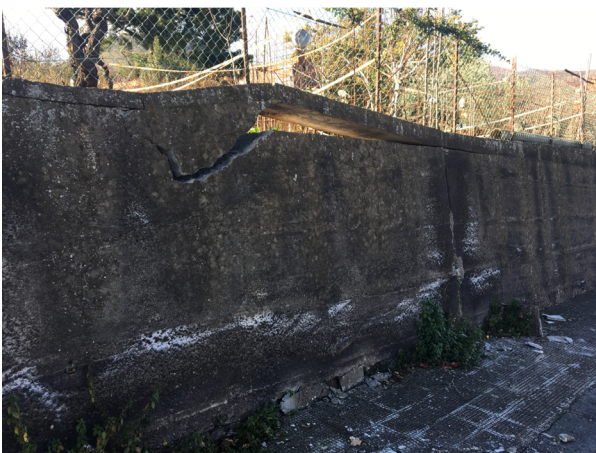
Foto 8 – Danni alla chiesa di Fleri, ad edifici privati e deformazioni permanenti nelle strade e nei muri a seguito del terremoto del 26.12.2018.
