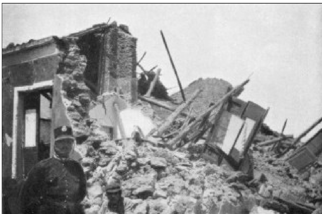
Foto 5 -. Passopomo (Zafferana E.): crollo di una casa in muratura costruita con pietre non squadrate (Platania, G., 1915)
