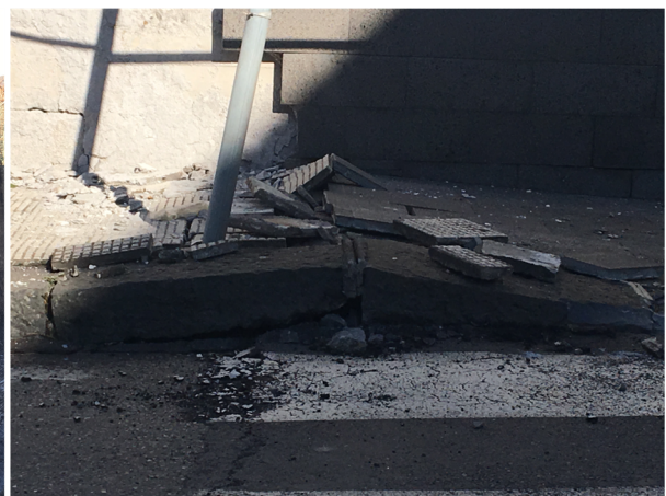
Foto 8 – Danni alla chiesa di Fleri, ad edifici privati e deformazioni permanenti nelle strade e nei muri a seguito del terremoto del 26.12.2018.
